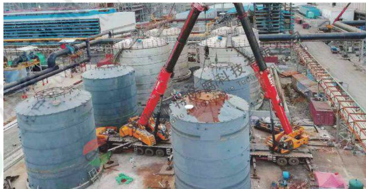
成品现场就位 (内衬大贮罐)
