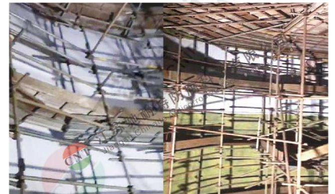
内衬现场施工中 (1300m 3 贮罐)
