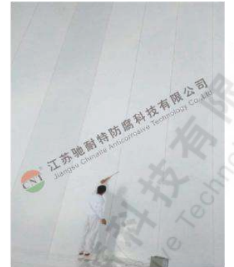
电火花检测 (大贮罐现场)
