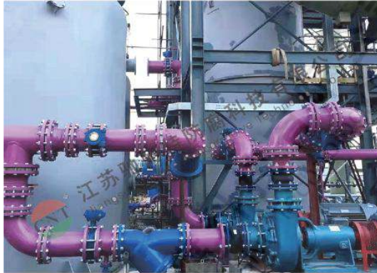
钢衬四氟 (管道现场安装)
