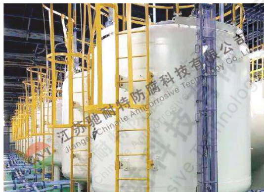
New-PTFE内衬 (电子化学品贮罐)
