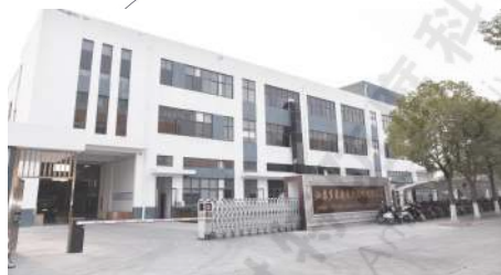
江苏多氟龙防腐技术有限公司
